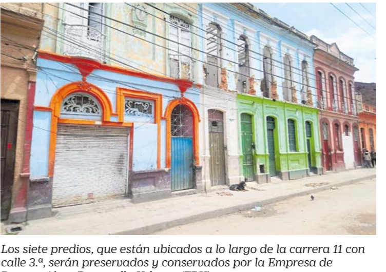
Los siete predios, que están ubicados a lo largo de la carrera 11 con calle 3ª, serán preservados y conservados por la Empresa de Renovación y Desarrollo Urbano (ERU).
