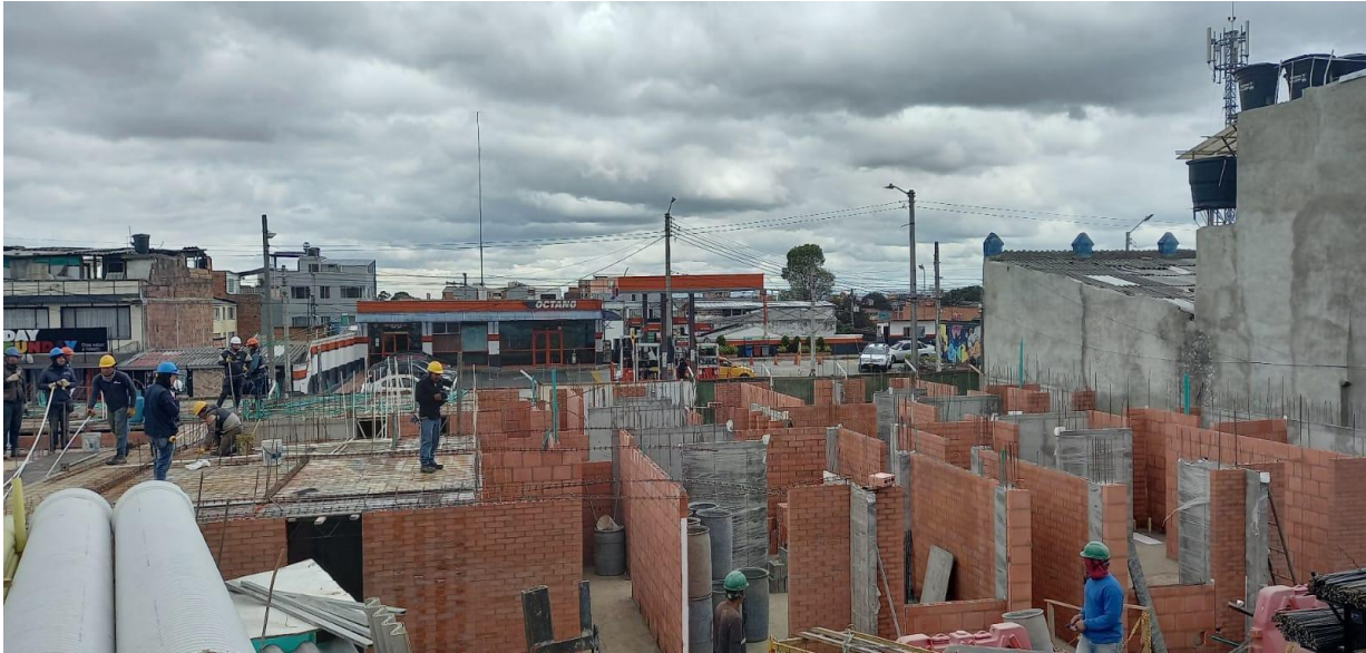
Auditoría Interna Obras y/o Proyectos. Visita de la obra, el 27 de agosto de 2026
