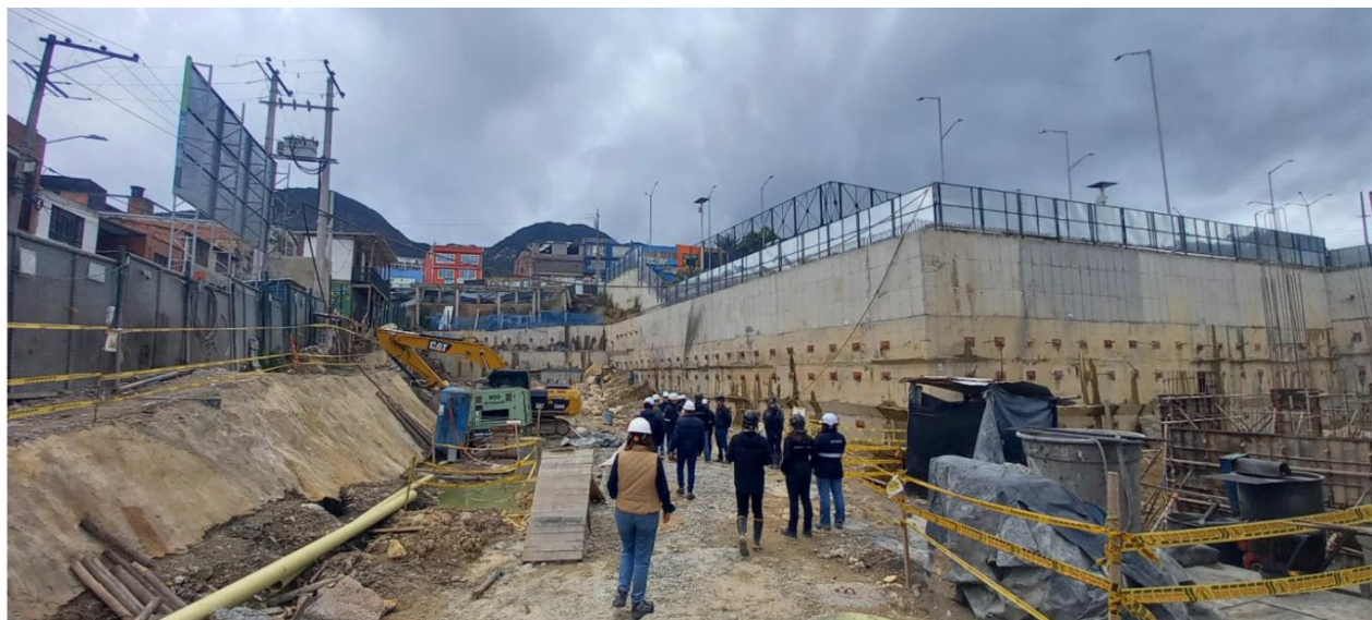
Auditoría Interna Obras y/o Proyectos. Visita de la obra, el 27 de agosto de 2026
