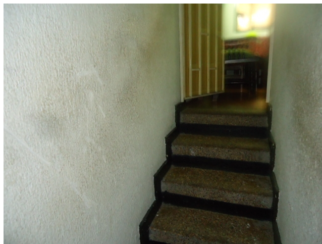
Escaleras a segundo nivel
