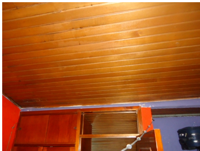
Habitación tercer piso techo machimbre
