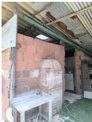
Vista Interna 1 piso teja
