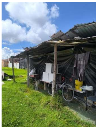
Fachada 1 piso teja
