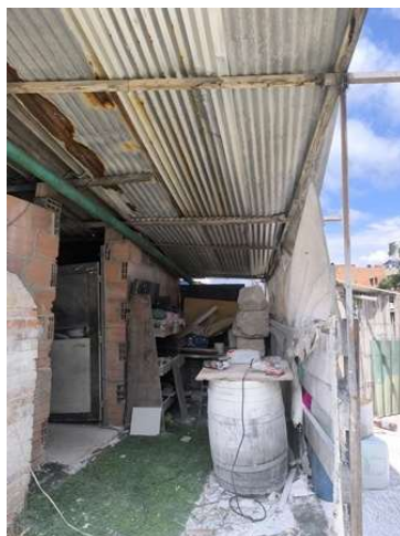
Vista Interna 1 piso teja
